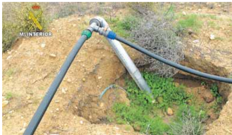
Toma del sondeo para captar las aguas subterráneas. :: G. C.
